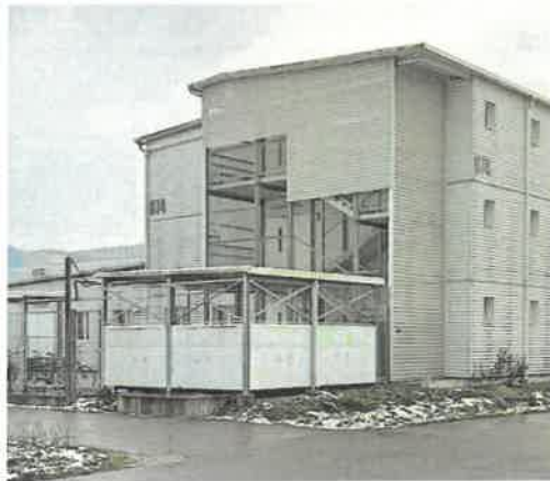
Diese Modulbaute von Hoffmann-La Roche, die derzeit noch in Kaiseraugst steht, dient in Oftringen künftig als Asylunterkunft. Bild: Kanton Aargau/zvg
